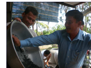
La construction du filtre à sable par les habitants
